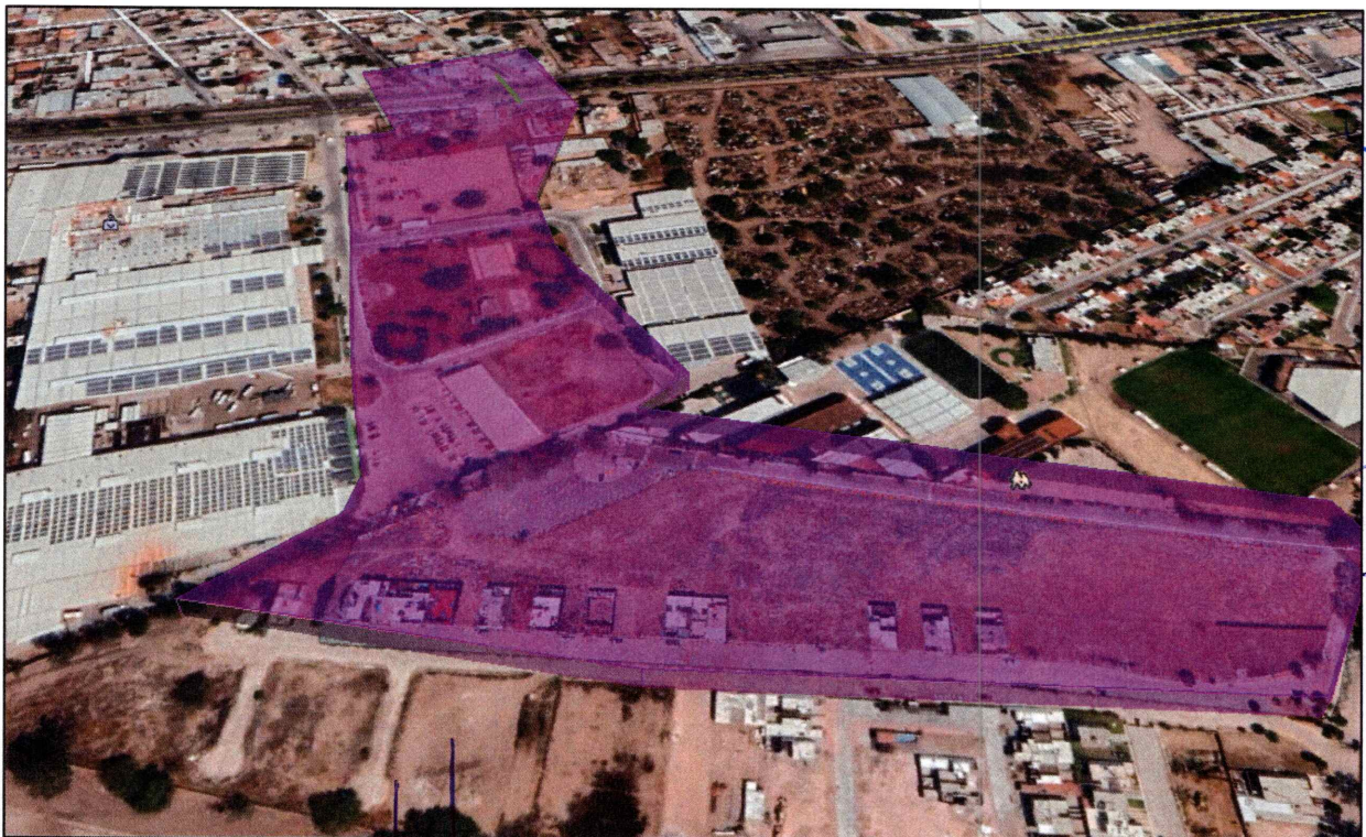
Figura 1 Zonas de revisión para la actualización de la Grieta Ruiz Cortinez 8.79 Ha.
