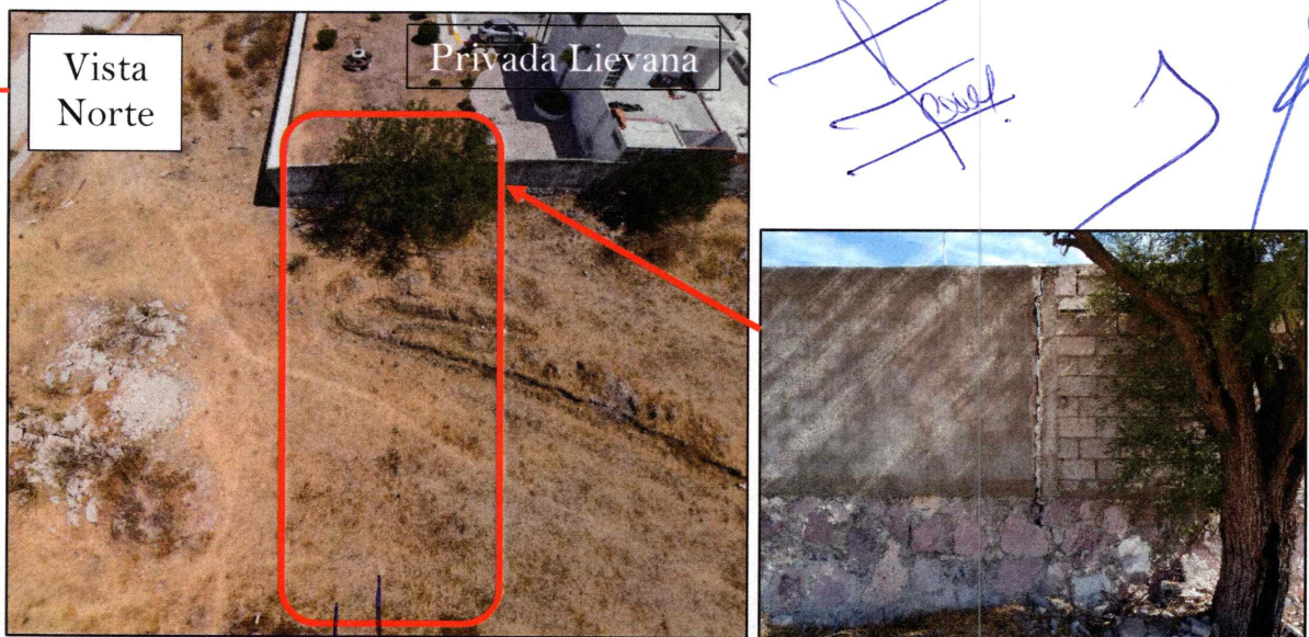
Figura 10 tramo 5 detectado en superficie al sur del desarrollo "Privada Lievana"
