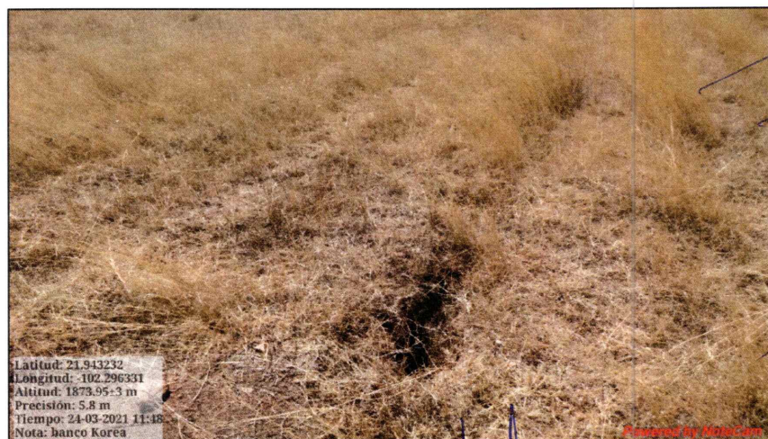
Figura 9 Ejemplo del agrietamiento observado
